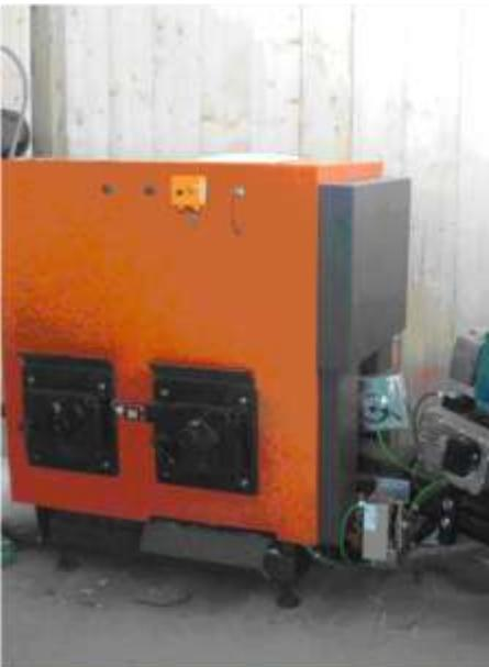
En las Islas Cíes, la caldera instalada en la Casa de los cuidadores del Museo da agua caliente y calefacción a una superficie de 700 m<sup>2</sup>. La caldera de biomasa tiene una potencia de 50 kW y el silo de almacenamiento tiene una capacidad de 27m<sup>3</sup>. La materia prima proviene de los restos de tratamientos silvícolas de los montes existentes en el Parque Natural de las Islas Cíes.
